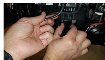
Dra forsiktig ut ledningene i powermodulen
