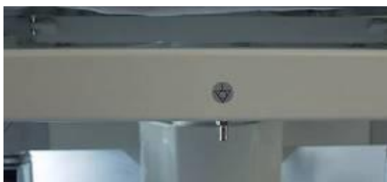
Fig. 1 Potentialutjämningskontakt – hane
