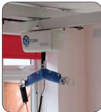
2 OT200 montert i traversskinne med ladestasjon.
