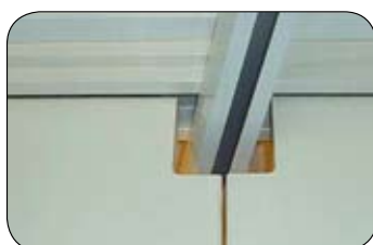
2 Takskinne ført gjennom dobbel skyvedør.
