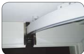
1 Takskinne ført gjennom vegg over dør.
